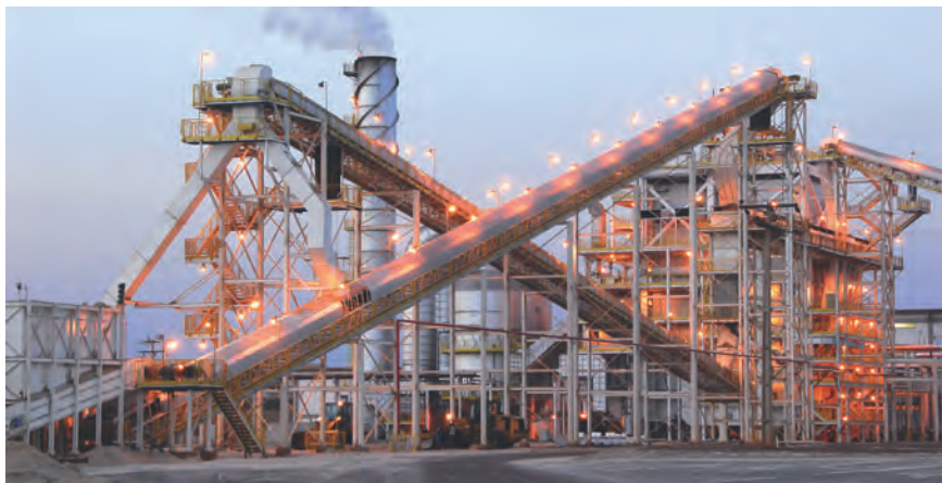
As novas unidades com tecnologia de ponta, como a Boa Vista, em Goiás, do Grupo São Martinho, já estão preparadas para parada reduzida
